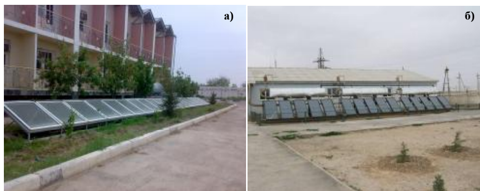
Рис. 5. Гелиоустановки: а) ПО «НМЗ», база отдыха «Лазурная», б) РУ-5, ГТР месторождения «Северный Канимех»
